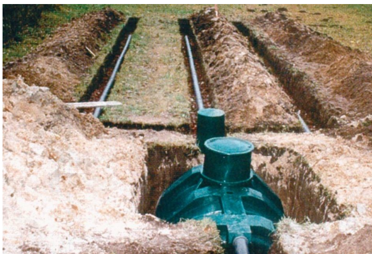
Rys. 3. Oczyszczalnia ścieków w trakcie wykonywania robót budowlanych
